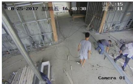
Chantier de construction
